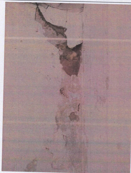
zdj. 10 Zawilgocenia ścian piwnic
