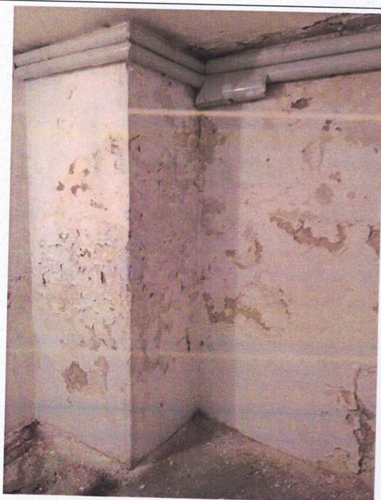
zdj. 11 Zawilgocenia ścian piwnic
