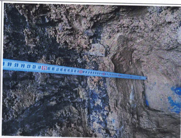
Zdj. 2 Odkrywka fundamentu – wysokość fundamentu
