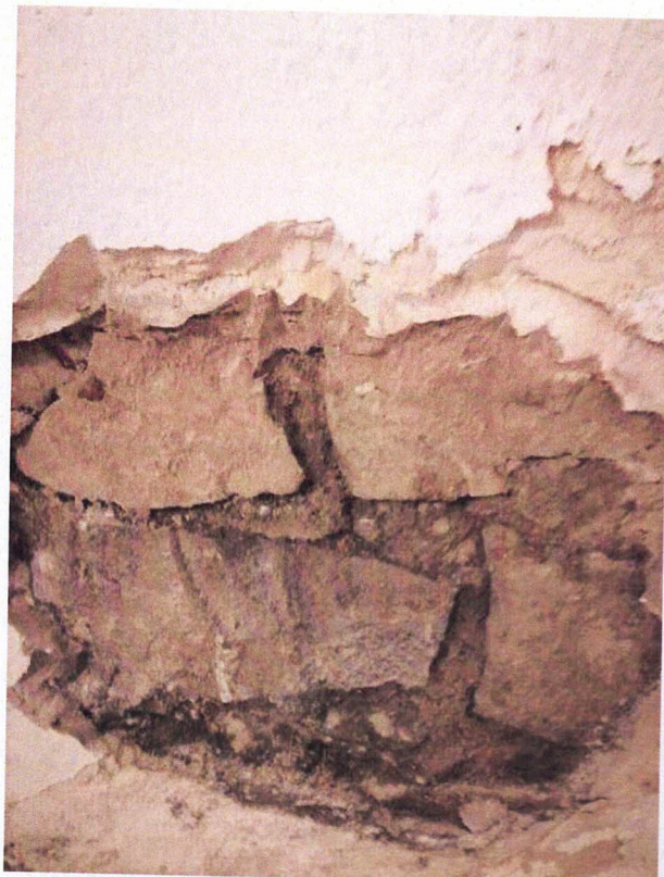
zdj. 7 Odkrywka ściana z kamienia łamanego
