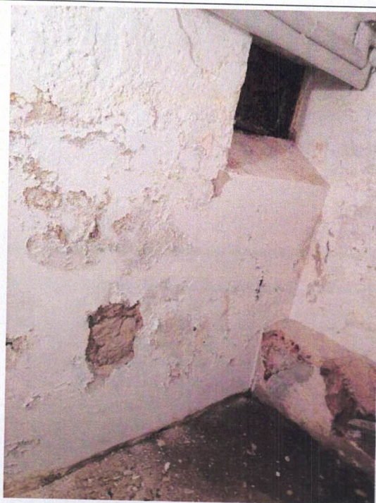
zdj. 10 Zawilgocenia ścian piwnic
